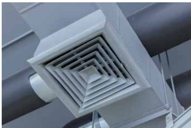
Vetrací systém by sa mal pri výmene filtrov odstaviť, servisní pracovníci by mali použiť všetky potrebné osobné ochranné pomôcky a filtre odovzdať na likvidáciu v uzavretom obale.
