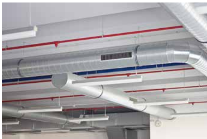
Dezinfekčné ošetrenie vzduchovodov po pandémii sa neodporúča.
